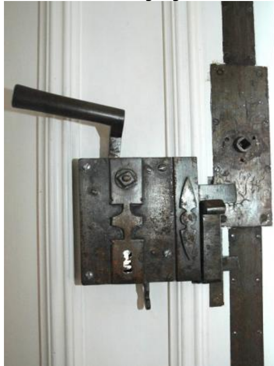
Foto: Christamaria Ruch Alle Rechte beim Urheber Ein gut erhaltenes, altes Kastenschloss ziert die Eingangstür.
