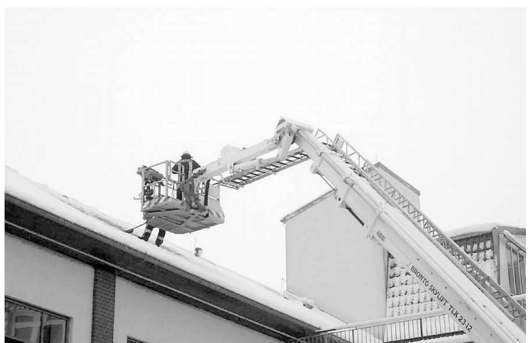
Mit dem „Bronto“ erreichten die Feuerwehrleute das Dach des Klinikums.
