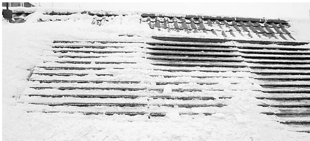
Die Lufteinlässe für die Klimaanlage, die auch den Operationstrakt versorgt.
